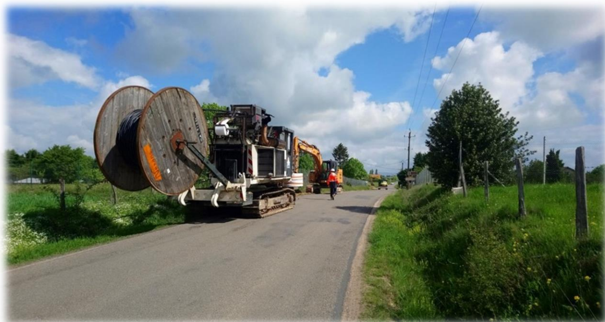
Exemple de chantier d'enfouissement de câble le long d'une voirie (source : sciepd)
