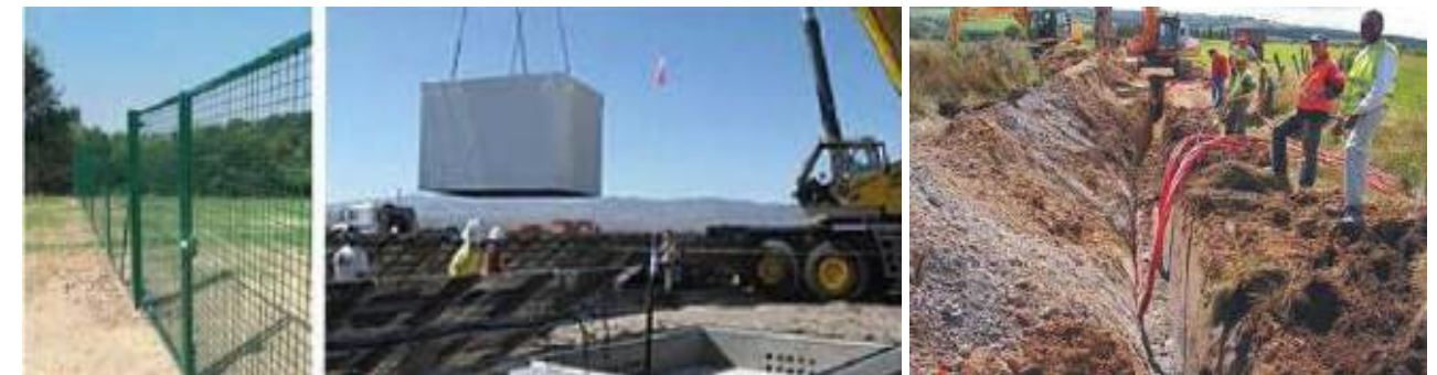
Illustration 85 : Exemple de chantier d'un parc photovoltaïque au sol
